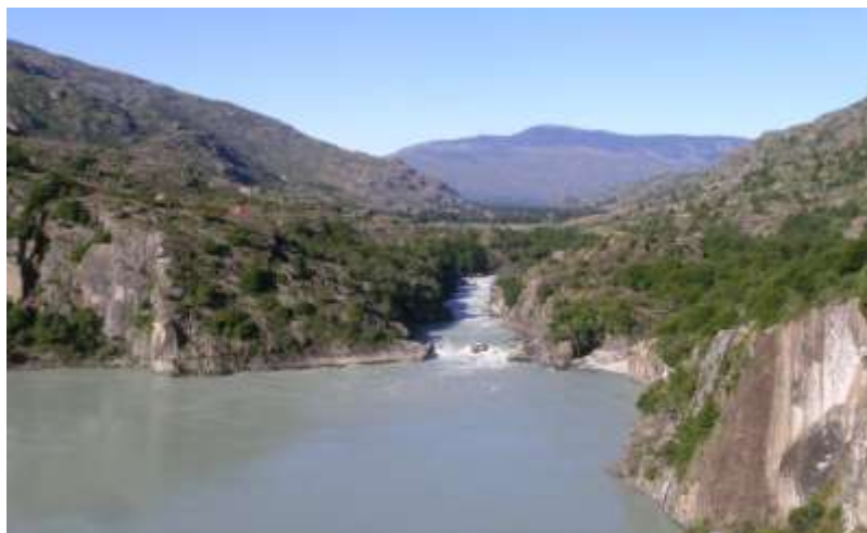
Angostura El Saltón, Río Baker. Punto en que se construiría Central Baker 2, Proyecto hidroeléctrico Hydroaysén - Fotografía Carlos Garrido
